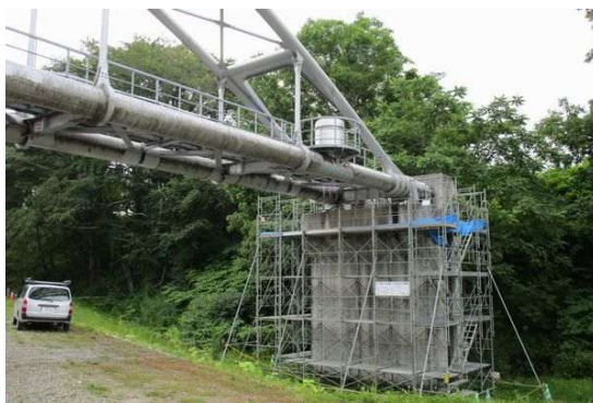
札内川水管橋耐震補強工事
