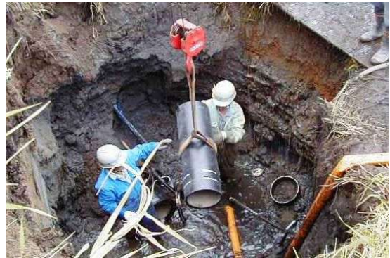
平成 15 年十勝沖地震復旧工事（池田町）
